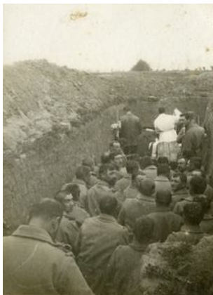
Messe dans une tranchée à Hébuterne
