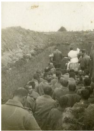
Messe dans une tranchée à Hébuterne
