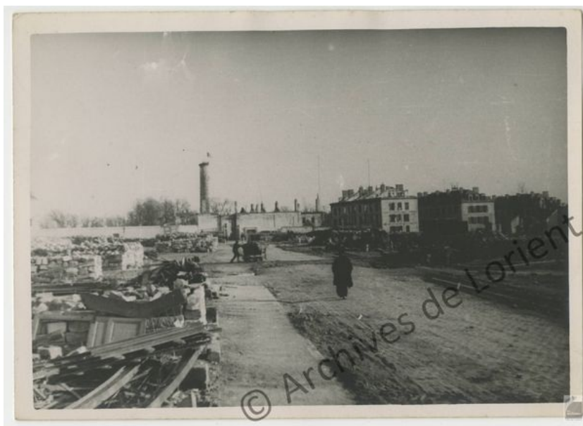
Déblaiement autour de la porte Gabriel, 1945 © Archives de Lorient – Fonds Jean-Pierre Fumoleau - 63 Fi 91
